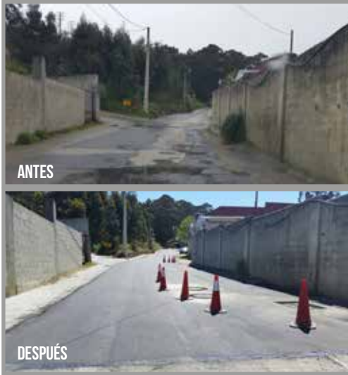
Rebacheo en Camiño de Agrela ao Martinete, solicitado por la Asociación al Ayuntamiento de A Coruña (antes y después)
