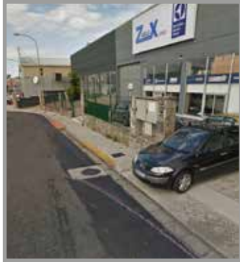
Reposición de arqueta deteriorada (en el centro de la imagen) en la calle Marie Curie.
