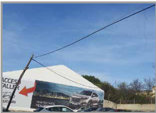
Retirada de poste telefónico deteriorado en las instalaciones de la empresa asociada Finisterre Motor.
