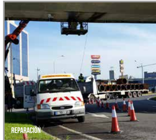
Reparación de las filtraciones del paso superior de la Ctra. de Carballo sobre la rotonda Eduardo Díz
