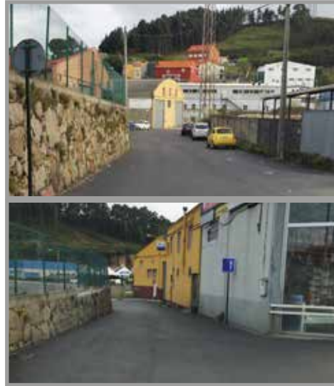
Asfaltado en la entrada a O Bosque desde la vía de servicio de la Ctra. de Carballo.
