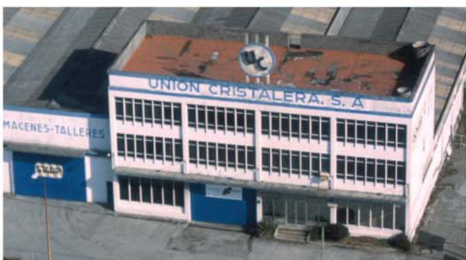
Arriba la imagen actual de la nave de Portaglas, abajo las instalaciones antes de su reforma
