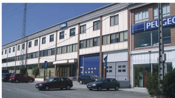
Arriba la imagen actual de Automóviles Sánchez, abajo las instalaciones antes de su reforma
